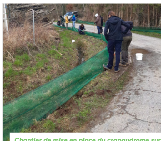
Chantier de mise en place du crapaudrome sur Pierrepont sur l'Arentèle avec les bénévoles et les étudiants du CFR de Gugnécourt. / CCB2V
