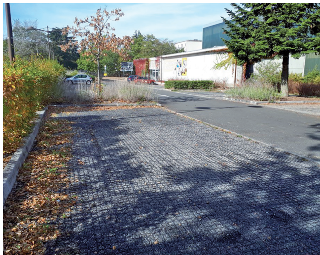
Exemple de dalles PVC avec remplissage gravillonné (© Wendy Arnould, Pole Dream)
