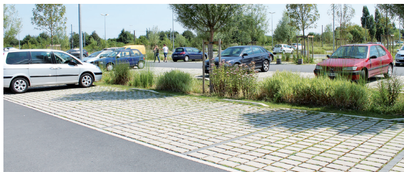
Exemple de pavés à joints élargis (©Adopta - Maëlle Ancelle)
