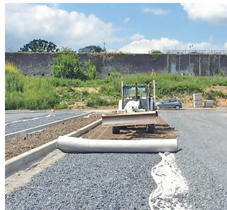
Pose d'un géotextile (© O2D, Esplanade du Champ de Mars - Lille)
