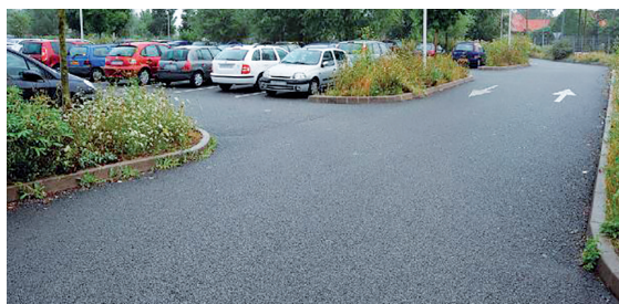
Enrobé poreux sur structure réservoir (© Lille Métropole)
