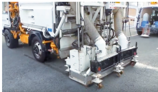
Décolmatage par pression/aspiration (© Sotraveer)
