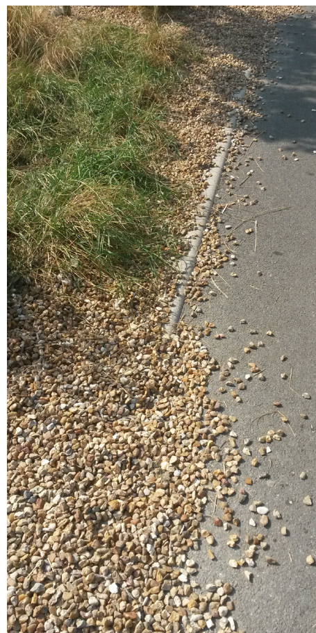
Exemple de mauvaise adéquation entre choix de bordure, usage et nature du revêtement (© P&C – Robin Dagois)
