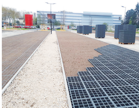
Pose de dalles alvéolées (© Wendy Arnould, Orléans)
