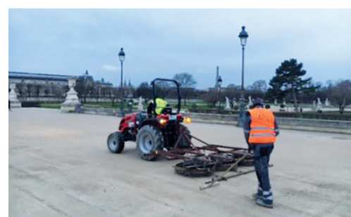
Ratissage d'un stabilisé - Parc des Tuileries (© DPAJ SDJ EPML Louvre)
