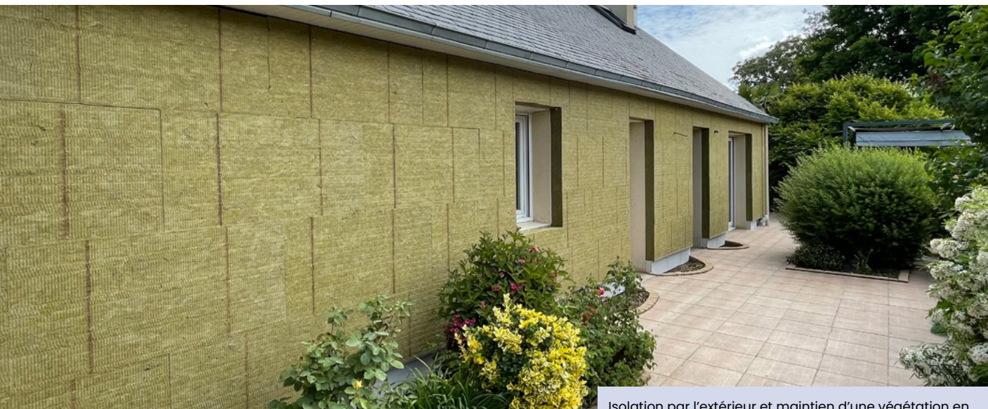
Isolation par l'extérieur et maintien d'une végétation en pied de mur | © Atelier de Brocéliande
