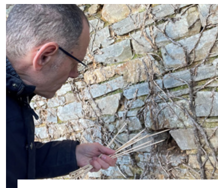
Repérage des anfractuosités à conserver avant réfection des joints I © Thierry Dupeux, agence RHIZOME Rennes-architectes
