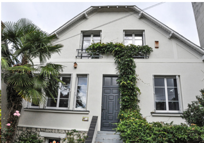
Avant (gauche) et après (droite) ravalement de façade | © Maxime Dépinoy, Plante & Cité
