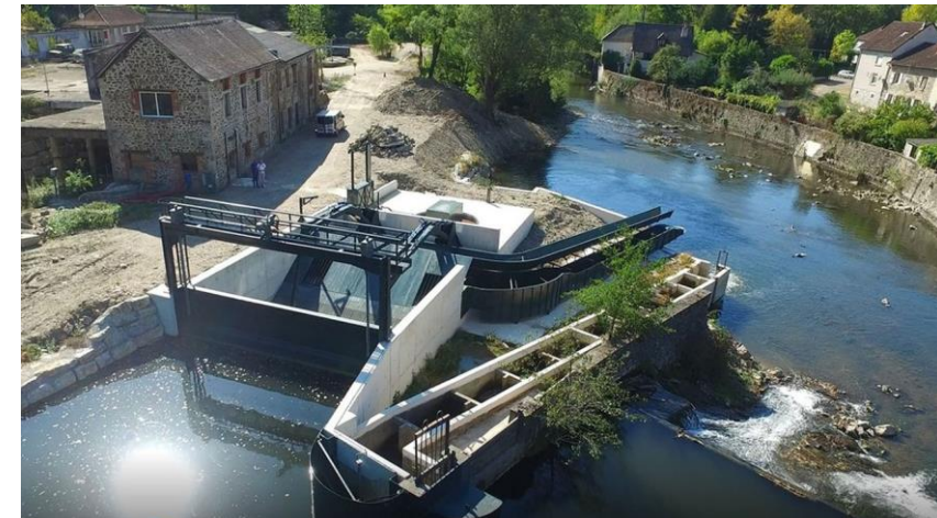
La centrale hydroélectrique de Clarendent, en Corrèze. (Valorem)
