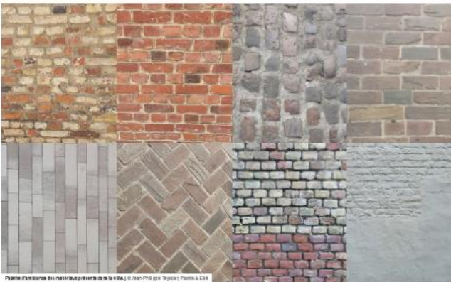
Paroi d'enceinte des murailles primitives de la ville. © Jean-Philippe Tessier, Plante à Cité
