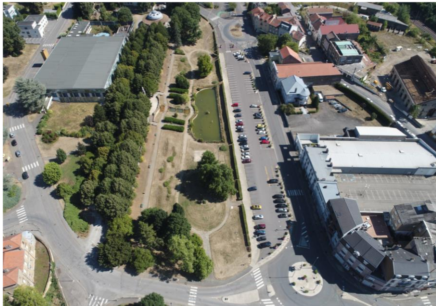
Juin 2022, avant démarrage du chantier
