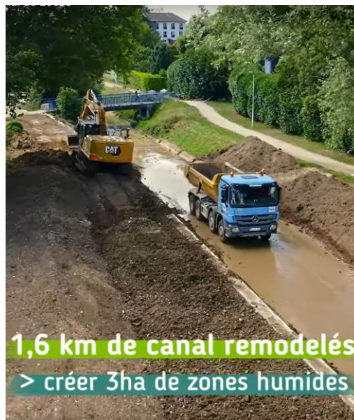
Travaux de débétonisation du canal de Loëze à Bourg-en-Bresse (01). MOA : Syndicat Reyssouze et affluents
