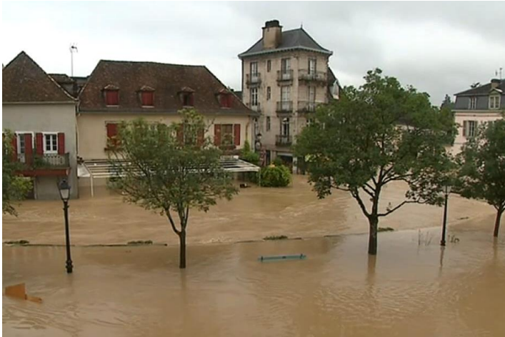
Récentes inondations dans le centre ancien de Salies-de-Béarn (64) en 2018 et 2024.
