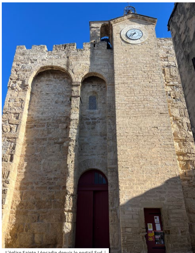
L'église Sainte-Léocadie depuis le portail Sud. | © mairie de Vic-la-Gardiole
