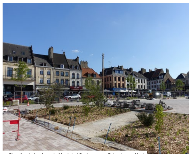
Chantier de la place du Maréchal Foch, agence Osty et associés. | © Sandrine Larramendy, Plante & Cité
