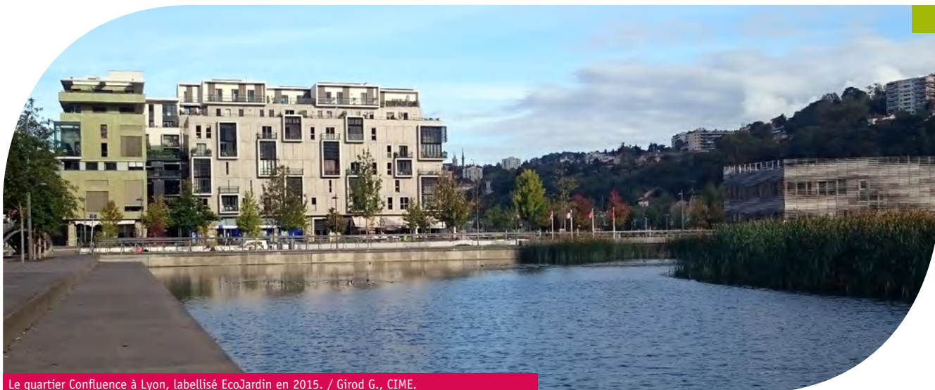
Le quartier Confluence à Lyon, labellisé EcoJardin en 2015. / Girod G., CIME.
