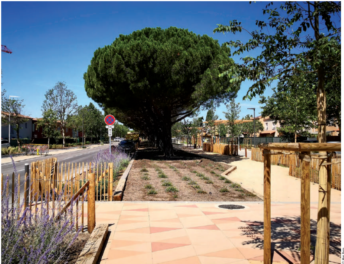
Requalification du boulevard Aubanel
