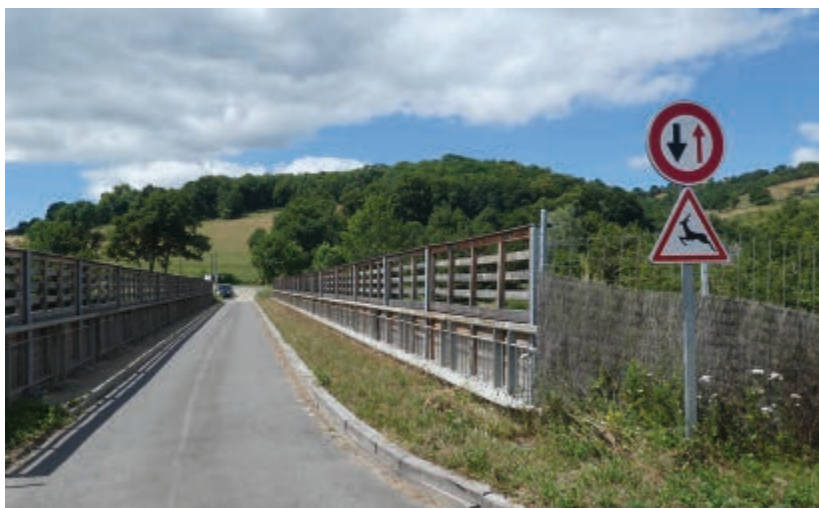
Banquette enherbée sur pont routier.
