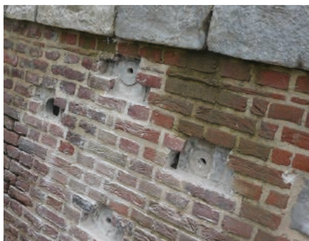
Nichoirs artificiels intégrés au parement et maintien de fissures auxquelles les chauves-souris sont sensibles.
